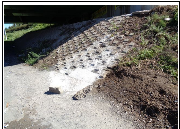
공동구간 보수 (A2)
