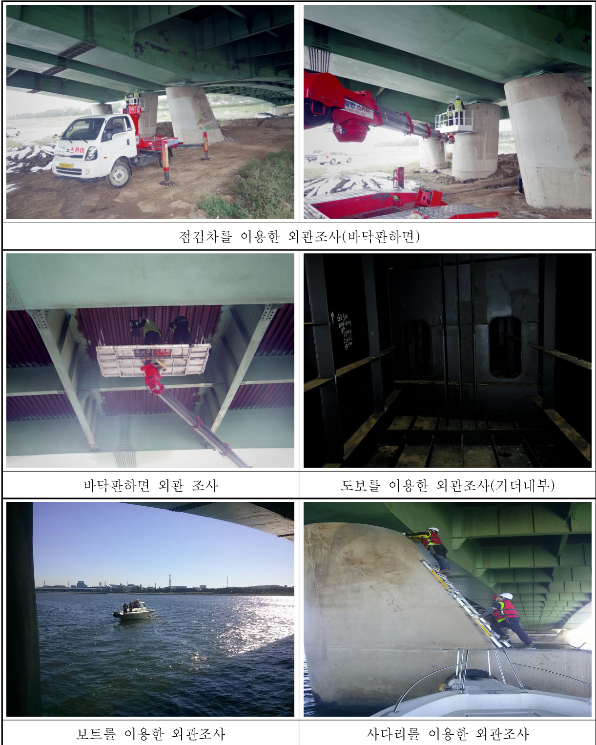
【그림 3.2】 외관조사 전경
