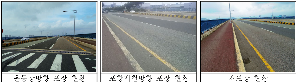
【그림 3.3】 교면포장 현황
