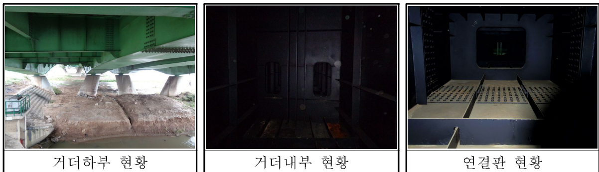
【그림 3.12】 Steel Box Girder 현황
